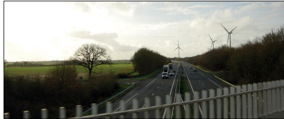
Le parc éolien Champs Chagnots à côté de l'Autoroute A10 Source : Résonance Urbanisme et Paysage 2020
