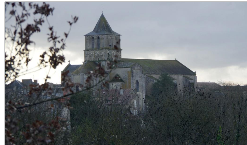
Eglise de Lusignan (MH21) en belvédère sur la Vonne
